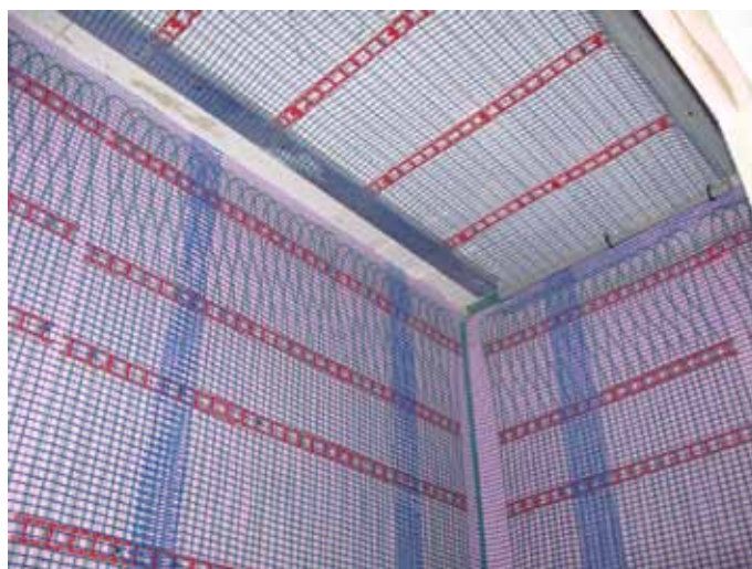
Obr. 9. Kapilární rohože stěnové a stropní před aplikací sádrové omítky
