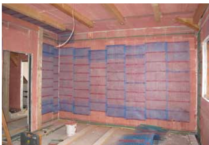
Obr. 2. Kapilární rohože stěnové na podkladní tepelné izolaci, aplikace v objektu rekonstrukce bývalé fary v Mahringu (Německo) (půdní vestavba realizována jako dřevostavba)
